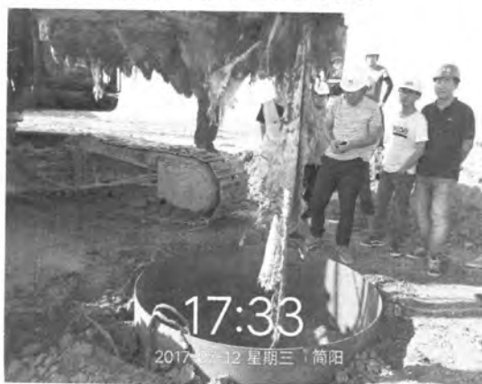
(图3a) 成孔过程中挖出地基处理褥垫层使用的土工布
